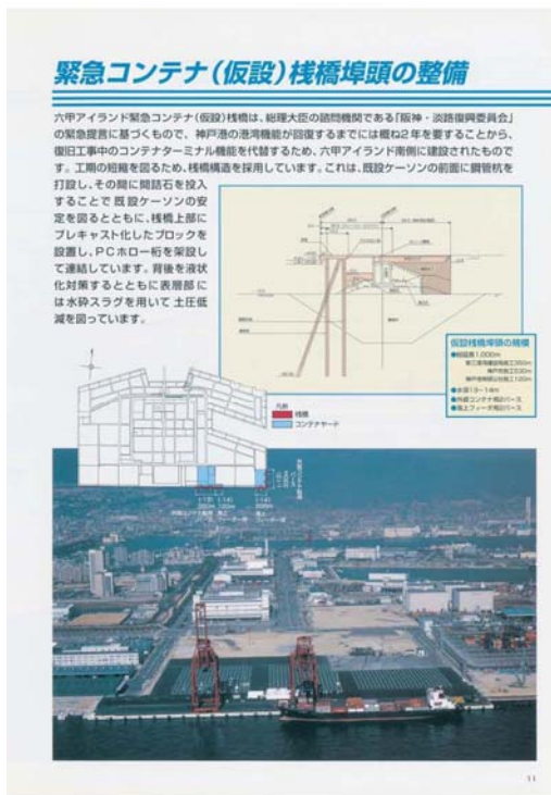
「蘇れ！より強く、しなやかに」 (運輸省第三港湾建設局震災復興建設部)
