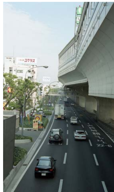
1997年復旧した阪神高速3号神戸線 (阪神・淡路大震災「1.17の記録」より)
