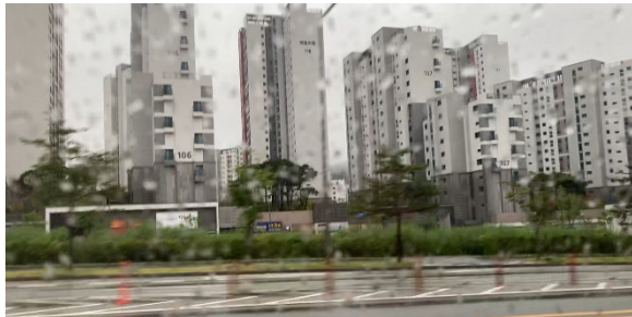
写真10 生活圏6の建設中の住宅
