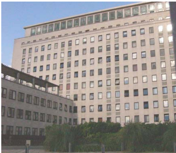
コンバージョン住宅（旧シェル本社） ロンドン テムズ川沿いに建つ公益企業のビルなども、民営化で売却され中～高級コンドミニウムとして供給された
