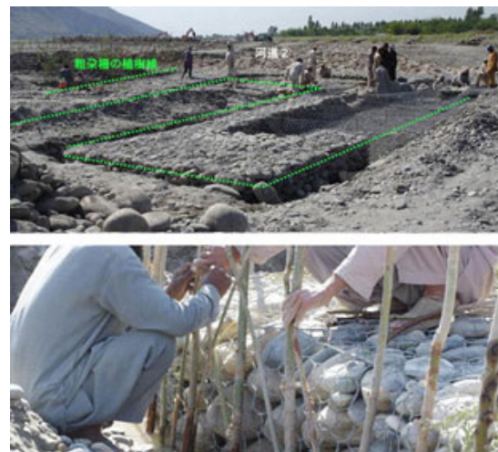
中村医師のアフガンの農用水路工事での粗朶沈床
